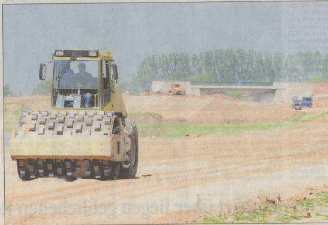
Die Bauarbeiten an der Ortsumgehung Wehrbergen sind in vollem Gange – wegen veränderter Ausschreibungsbedingungen wird aber erst in etwa einem Jahr mit der Fertigstellung gerechnet. Foto: Dana
