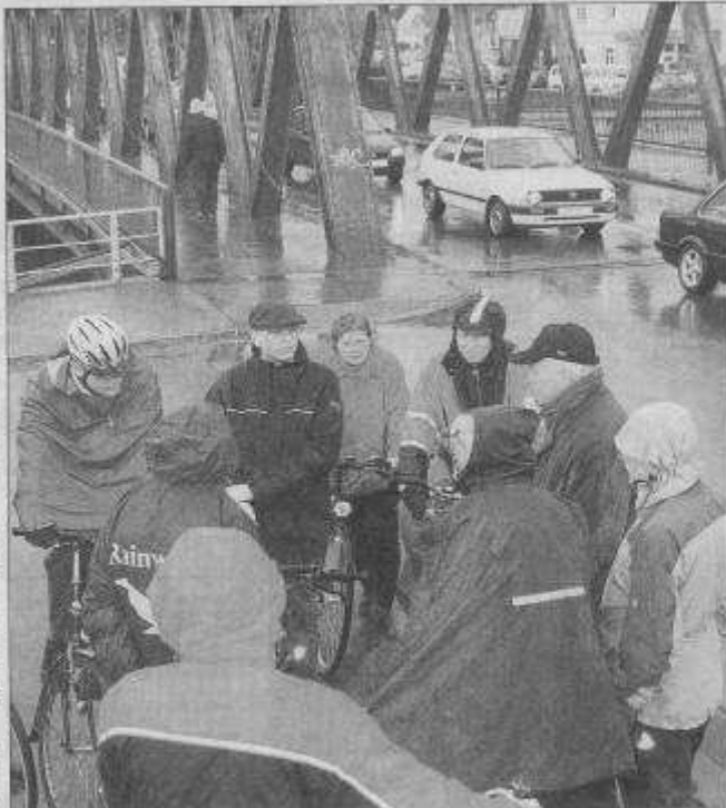
Kurzer Stopp auf der Münsterbrücke: Nach dem Neubau des Ostteils der Quere – Baubeginn ist im August – werden Radwege zu beiden Seiten entlanggeführt. Foto: ay
